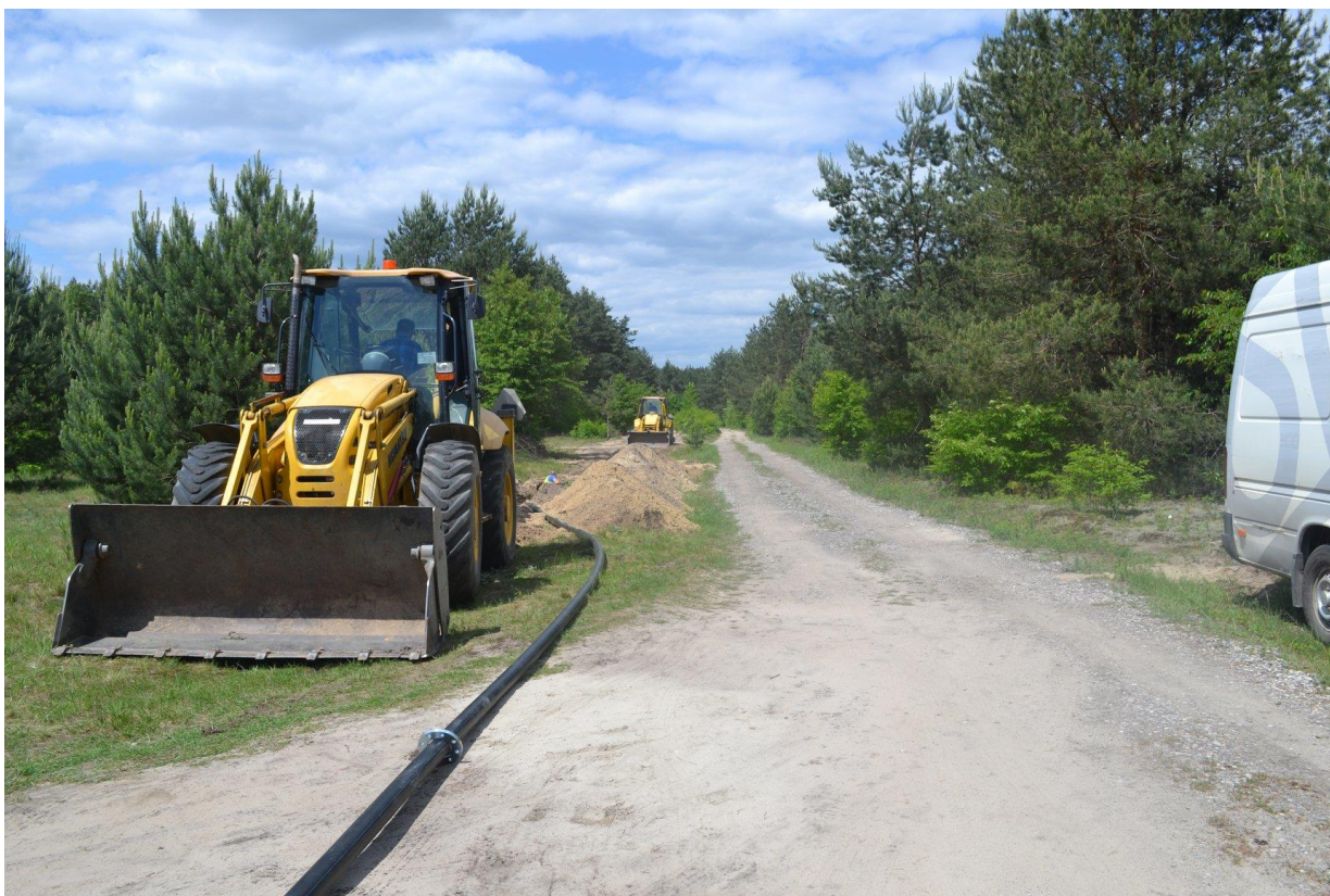
Rozbudowa sieci wodociągowej w Rudniku nad Sanem ul. Doliny
