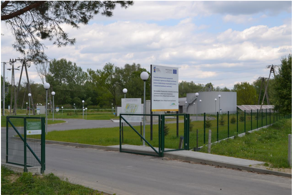
Oczyszczalnia ścieków w Rudniku nad Sanem
