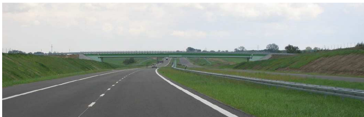
Droga poprowadzona w wykopie jest niewidoczna z terenów sąsiadujących z nią. Takie rozwiązanie pozwala też znacznie obniżyć nasypy dojazdu do przejazdu nad drogą.
