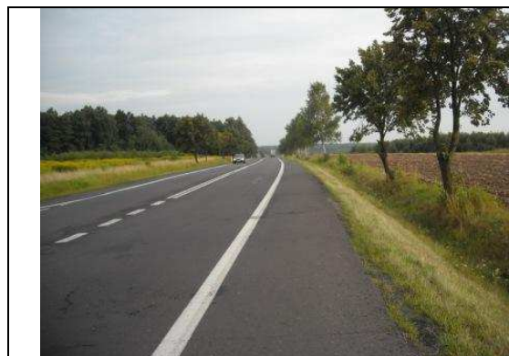
lokalizacja węzła „Kamień”, widok DK nr 19 kierunek Rzeszów
