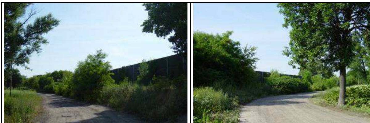
Przykład odbioru drogi z ekranem przeciwdźwiękowym wysokości 4m na nasypie ok. 2m - Krajobraz rolniczo - leśny
