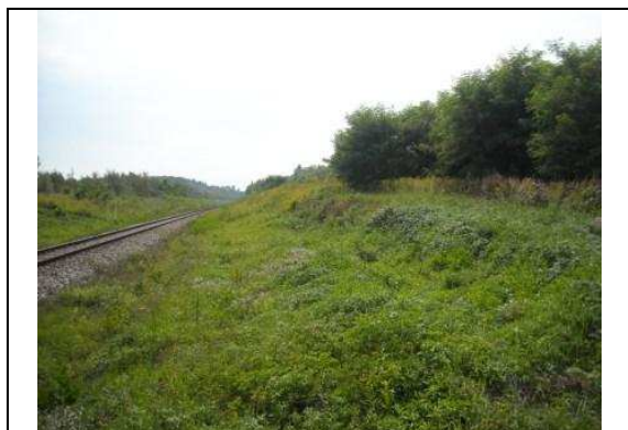
przecięcie z DW nr 858, widok południowy zachód
