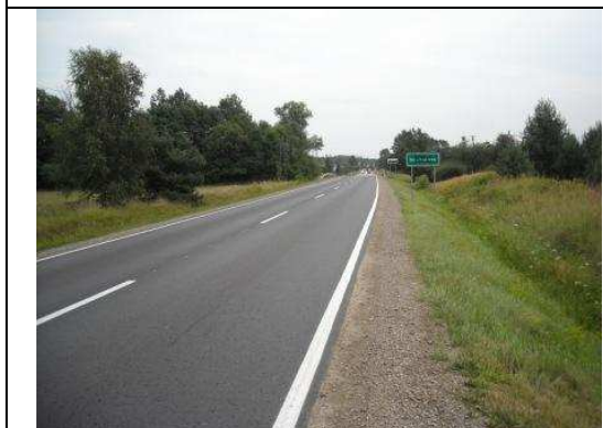
lokalizacja węzła „Nisko Pd”, widok DK 19 kierunek Rzeszów
