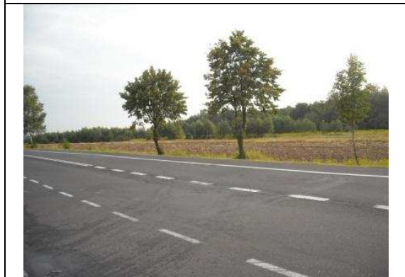
lokalizacja węzła „Kamień”, widok południowy zachód
