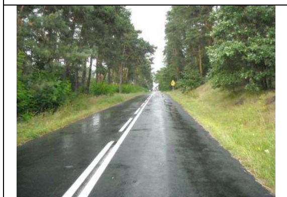
lokalizacja węzła „Podgórze”, widok DW nr 861 kierunek wschód
