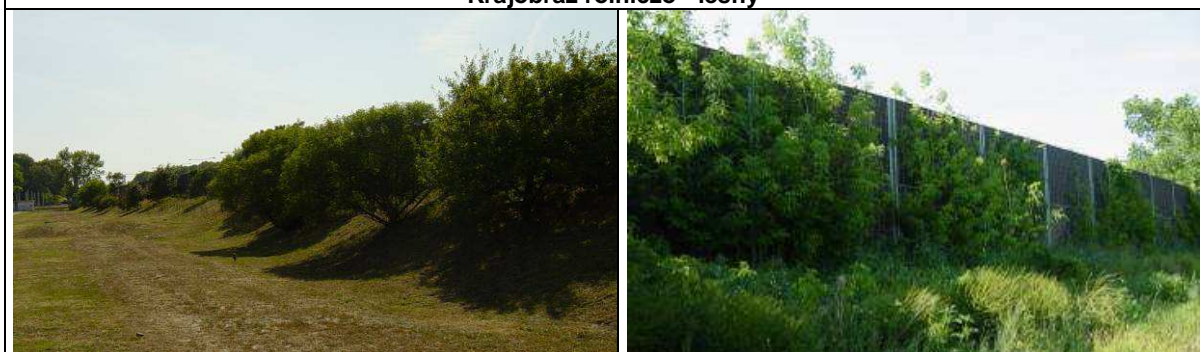
Przykład odbioru drogi z ekranem przeciwdźwiękowym wysokości 4m na nasypie ok. 2m - Krajobraz zarastających łąk
