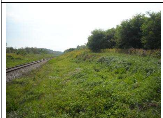
przecięcie z DW nr 858, widok południowy zachód
