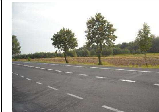
lokalizacja węzła „Kamień”, widok południowy zachód
