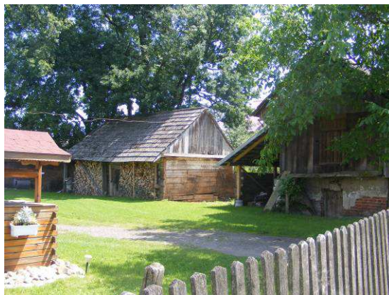
10. Zagroda nr 140 – stodoła drewniana z 1915r. Minimalna odległość od projektowanej drogi >1000m;
