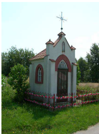
16. Kapliczka w Wólce Sokołowskiej z XIX/XXw, murowana, >1000m od projektowanej drogi;
