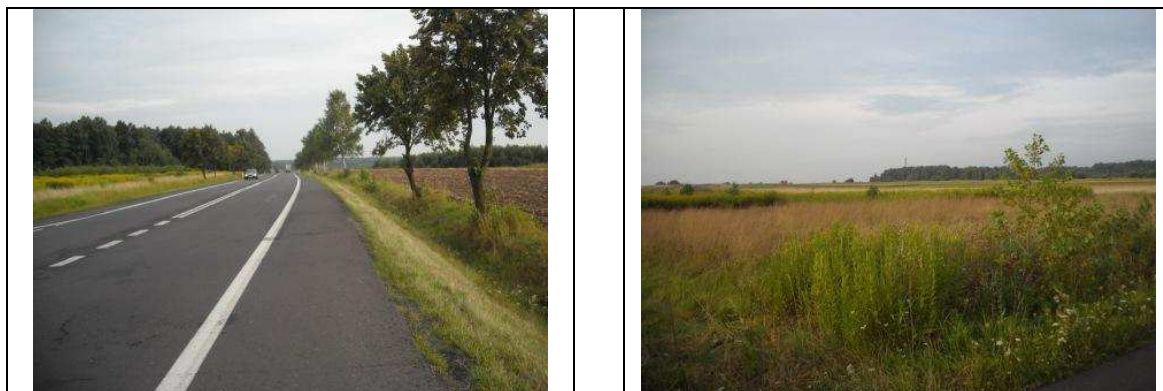
lokalizacja węzła „Kamień”, widok DK nr 19 kierunek Rzeszów
