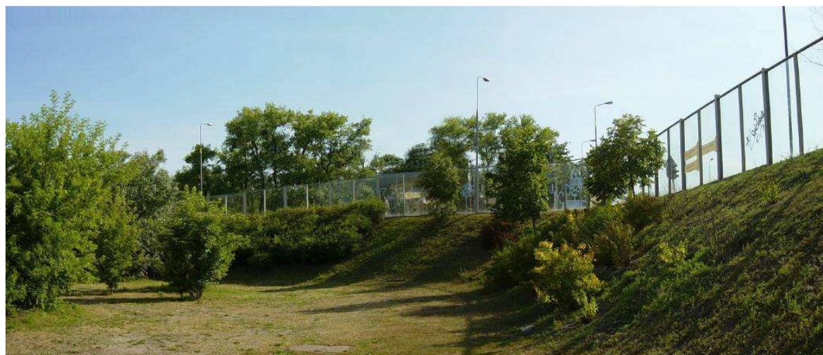
Przykład ekranu przezroczystego wysokości 4m na nasypie wysokości ok. 6m- Krajobraz rolniczy
