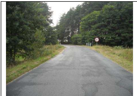
lokalizacja węzła „Nowy Kamień”, widok DP nr 1084R kierunek zachód
