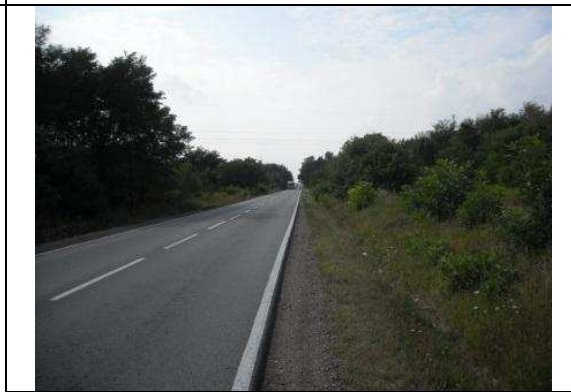
lokalizacja węzła „Nisko-Rudnik nad Sanem”, widok DK nr 77 kierunek Sandomierz
