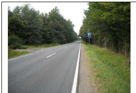
lokalizacja węzła „Nisko Pd”, widok DK 19 kierunek Lublin
