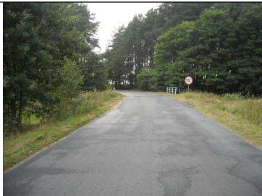
lokalizacja węzła „Nowy Kamień”, widok DP nr 1084R kierunek zachód
