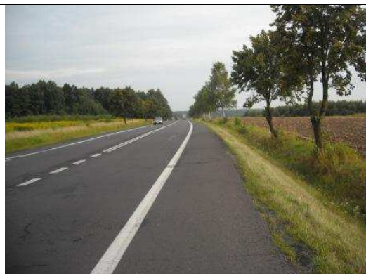
lokalizacja węzła „Kamień”, widok DK nr 19 kierunek Rzeszów
