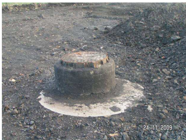
Fot. 26. Przykład zabezpieczenia studzienek w fazie budowy
