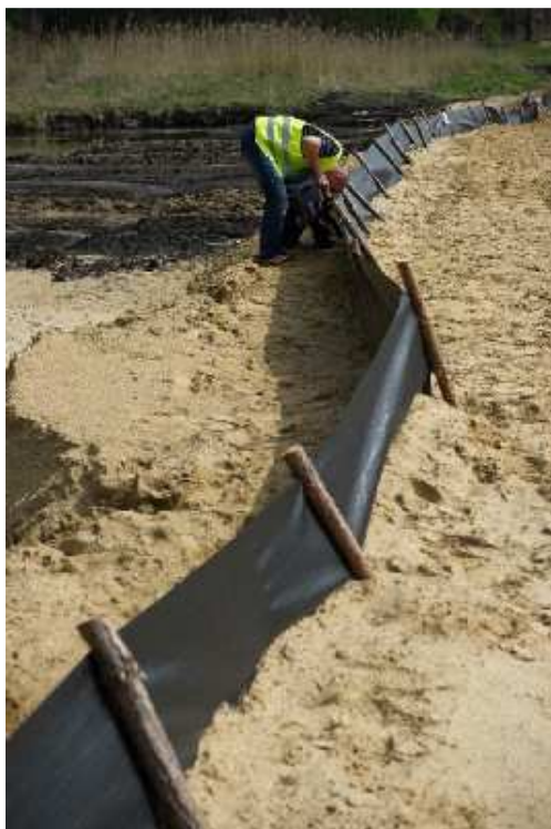
Fot. 25. Ogrodzenie ochronne na czas budowy
