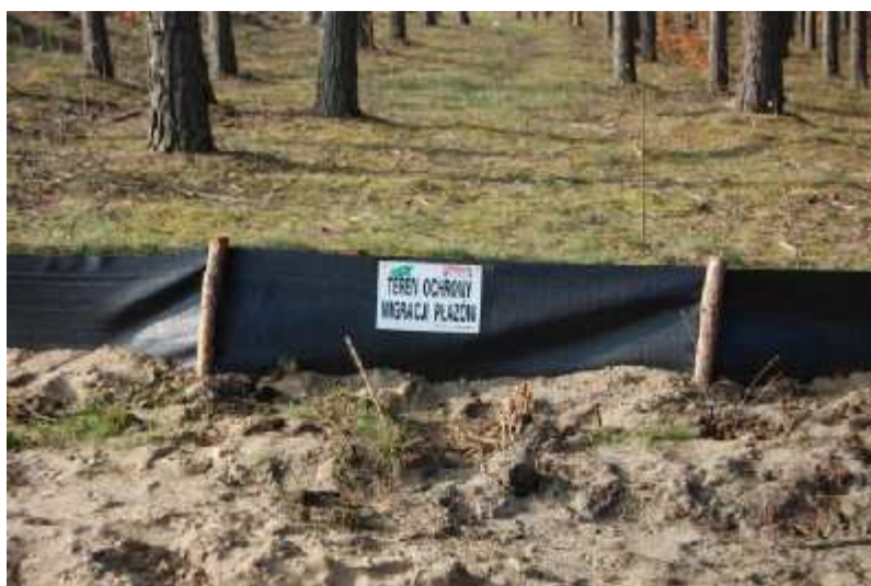
Fot. 24. Ogrodzenie ochronne na czas budowy
