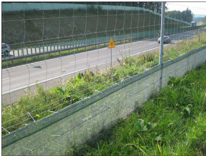
Fot. 27. Dodatkowe zastosowanie siatki ochronnej jako elementu naprowadzającego (fot. własna)
