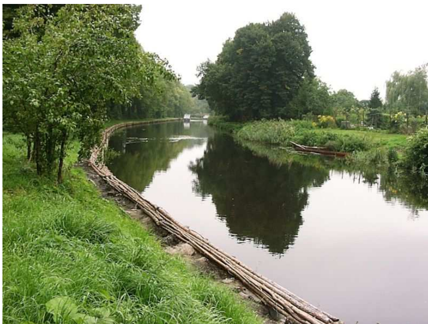
Rysunek 7.12. Regulacja rzek za pomocą faszyny.
