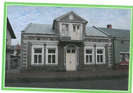
Rudnik nad Sanem - Dom, ul. Mickiewicza 29
