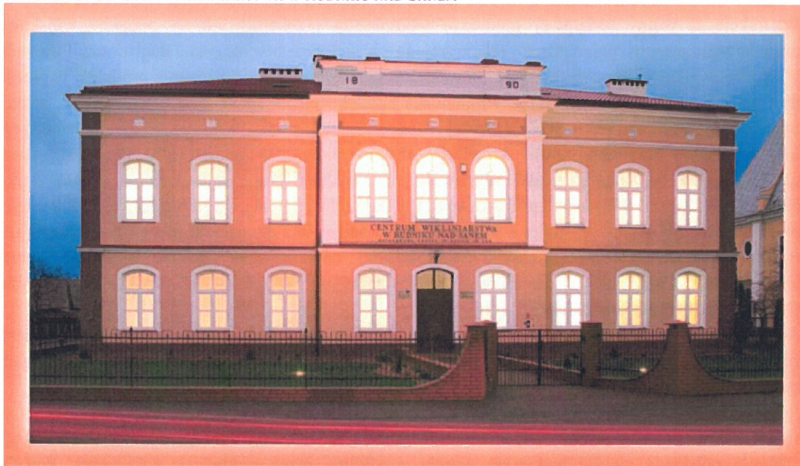
Dane: UGiM w Rudniku nad Sanem
