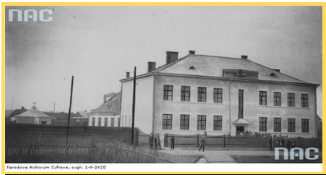
Rudnik nad Sanem – Budynek Państwowej Szkoły Rzemiosł, fotografia z 1933 r. w zbiorach NAC Warszawa
