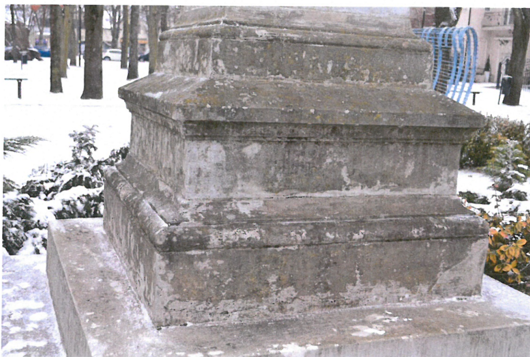
Fot. 2 Pomnik Ferdynanda Hompescha na placu centralnym rynku w Rudniku nad Sanem. Widoczny zły stan zachowania kamiennego cokołu oraz betonowej podstawy. Powierzchnia kamienia jest silnie zabrudzona, widać uszkodzenia piaskowca spowodowane czynnikami zewnętrznymi.
