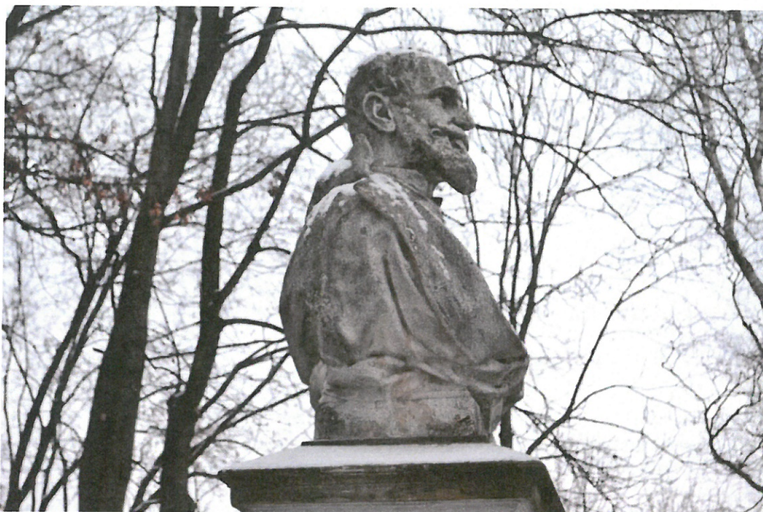
Fot. 1 Pomnik Ferdynanda Hompescha na placu centralnym rynku w Rudniku nad Sanem. Widoczny zły stan zachowania kamiennego popiersia hrabiego. Powierzchnia kamienia jest silnie zabrudzona, widać uszkodzenia piaskowca spowodowane czynnikami zewnętrznymi.
