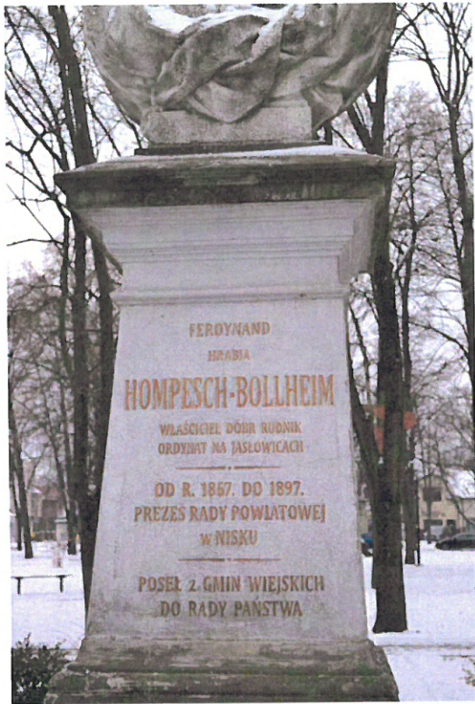
Fot. 3 Pomnik Ferdynanda Hompescha na placu centralnym rynku w Rudniku nad Sanem. Widoczny zły stan zachowania postumentu z inskrypcją. Powierzchnia tynku oraz kamienia jest silnie zabrudzona i skorodowana. Widać uszkodzenia spowodowane czynnikami zewnętrznymi.
